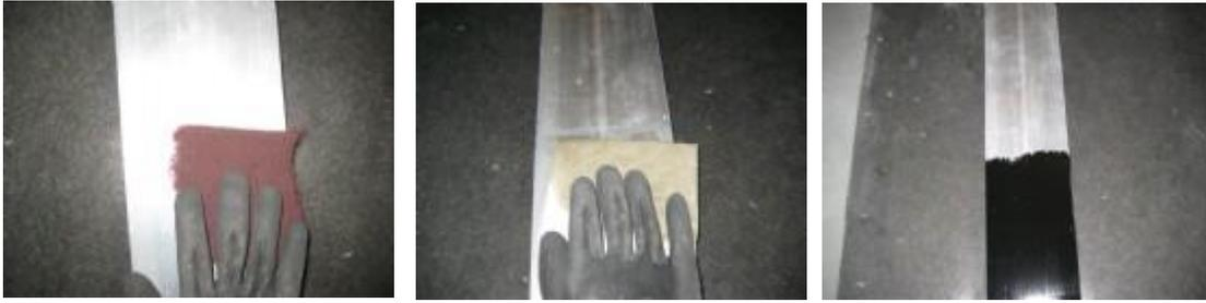
Zuerst wird die Unterkonstruktion mit einem Schleifvlies oder Gitter angeschliffen und danach mit einem Zellstofftuch und Sika Acivator205 gereinigt und 10 min. abgelüftet. Im dritten Schritt wird Sika Tack Panel Primer aufgetragen und min. 30 mind. max.8 Std. abgelüftet.
