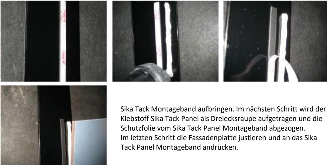
Sika Tack Montageband aufbringen. Im nächsten Schritt wird der Klebstoff Sika Tack Panel als Dreiecksraupe aufgetragen und die Schutzfolie vom Sika Tack Panel Montageband abgezogen. Im letzten Schritt die Fassadenplatte justieren und an das Sika Tack Panel Montageband andrücken.
